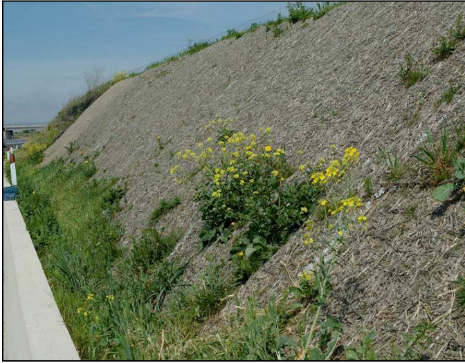
scarpata rivestita da biostuoie
