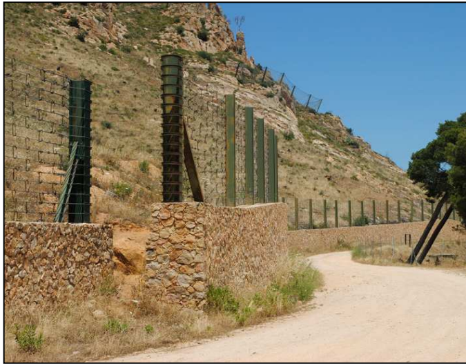
veduta d'insieme del sito con le reti paramassi e i muri protettivi a monte della strada sterrata
