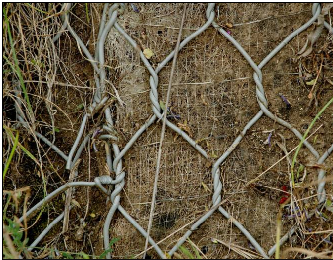
particolare della struttura della terra rinforzata
