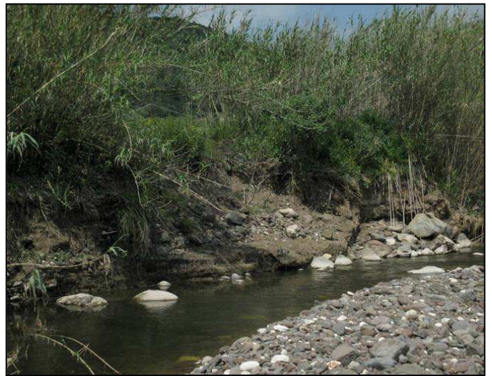
erosione spondale a monte dell'intervento
