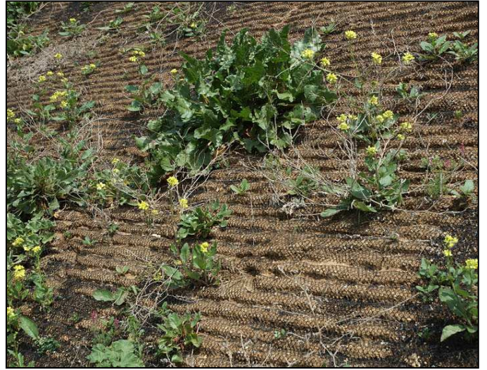
scarpata rivestita da geoteti
