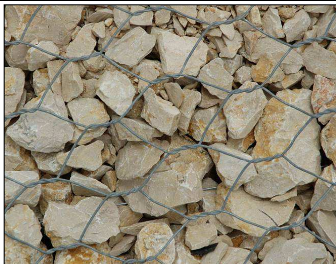
particolare della struttura dei gabbioni
