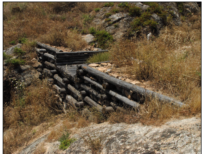
briglia in legno e pietrame realizzata lungo il compluvio
