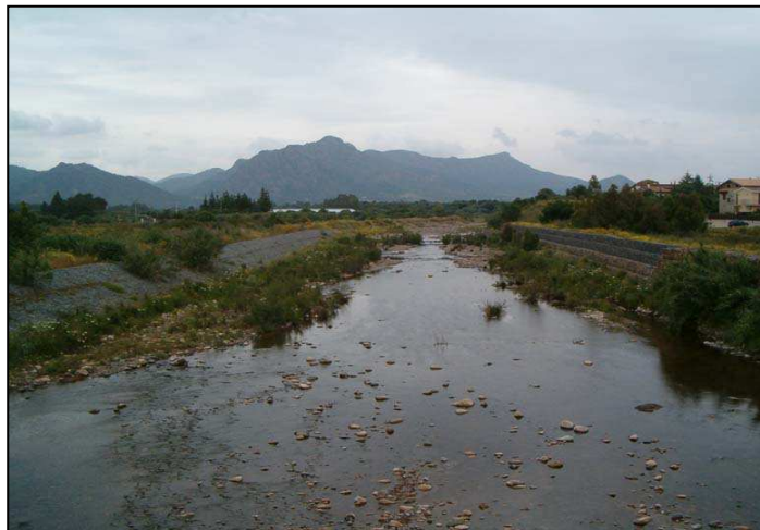
la parte dell'intervento situata più a monte
