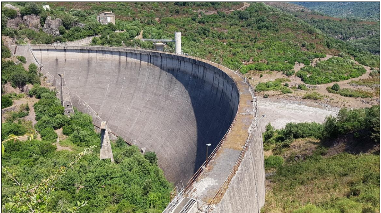
Figura 2 -Diga di laminazione sul Fiume Temo a Monte Crispu
