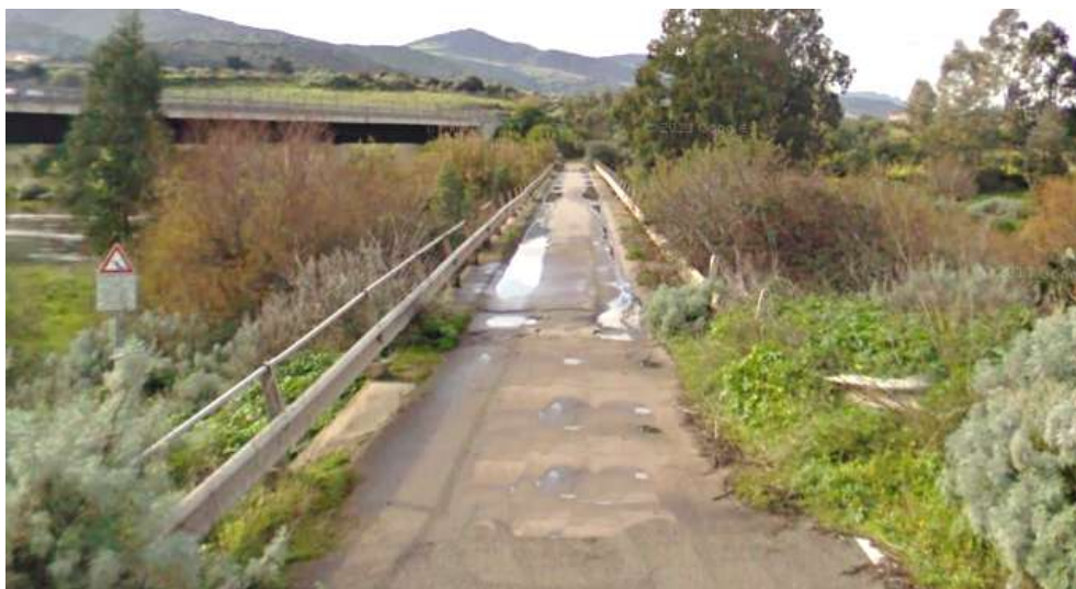
Figura 11.7 - Vecchia struttura di attraversamento presso Viddalba. Sulla sinistra si osserva il nuovo ponte.
