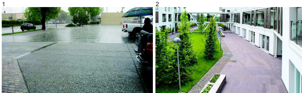
1 - Pavimentazione porosa 2 - Complesso residenziale in via Cenni, Milano, Italia - CZstudio associati + RossiProdi Associati
