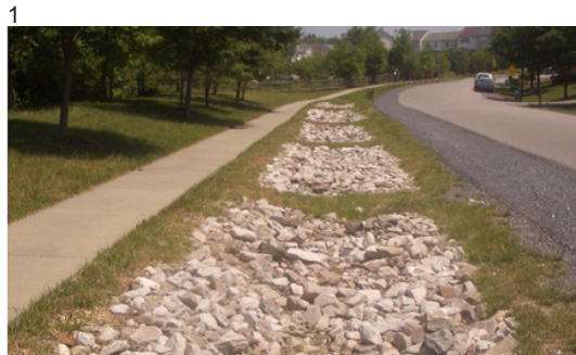
1 - Trincea di infiltrazione
