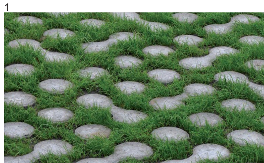
1 - Pavimentazione permeabile
